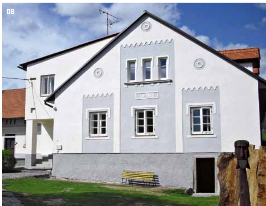
08 &gt; Obytný dům po obnově
