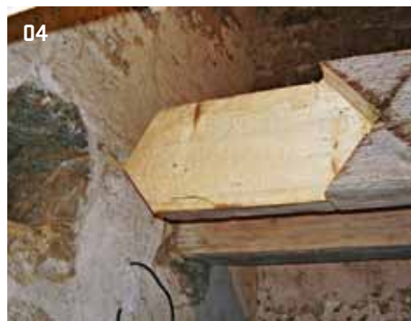
04 > Oprava dřevěných konstrukcí
