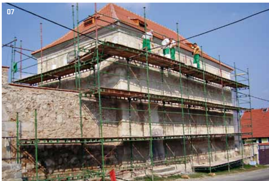
05, 06, 07 > Postup opravy sýpky
